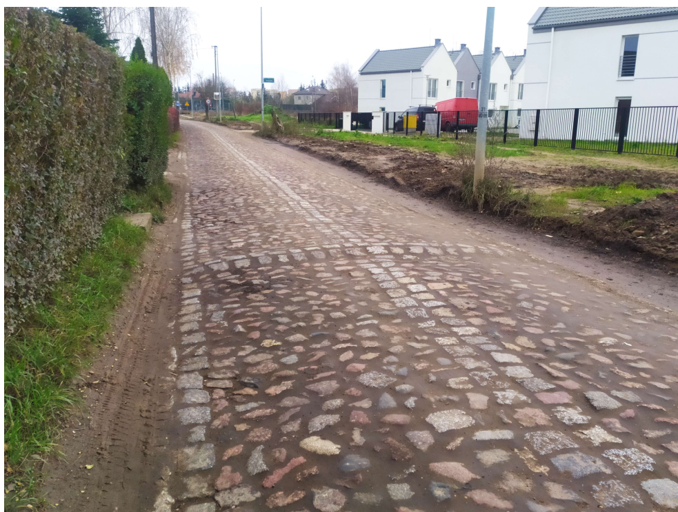
Rys. 4. Istniejący stan – kostka kamienna nadająca się do ponownego wykorzystania
