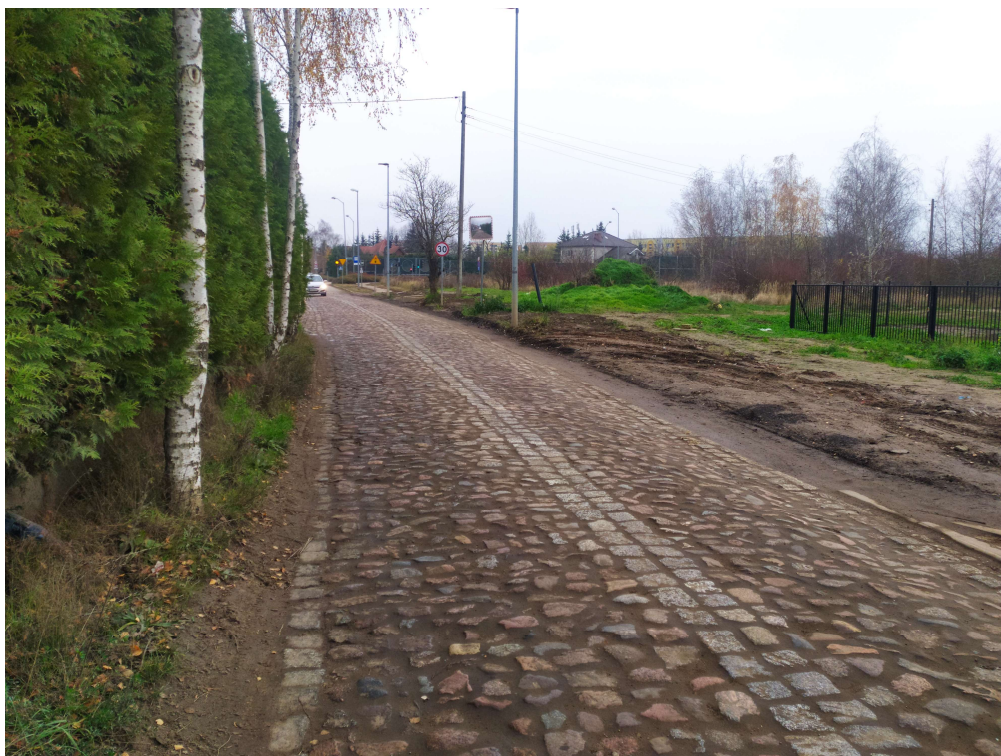
Rys. 5. Istniejący stan – kostka kamienna nadająca się do ponownego wykorzystania
